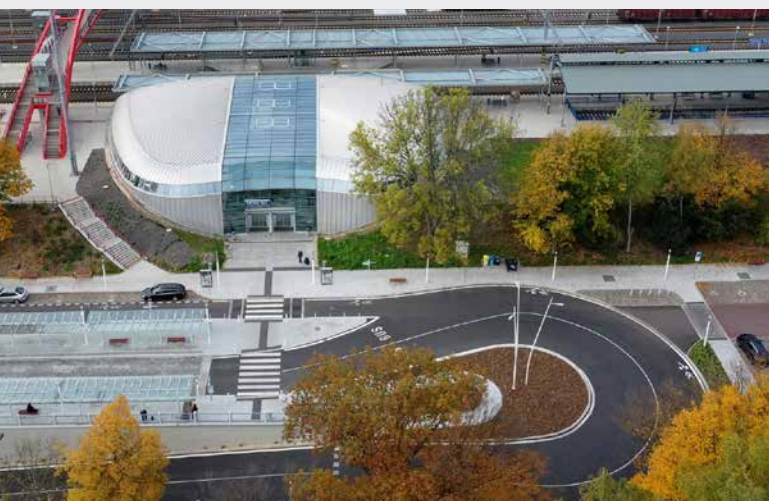
▲ Pohled na výpravní budovu s lávkou
